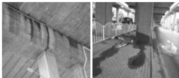
图2 雨后盖梁漏水和地面潮湿现象
