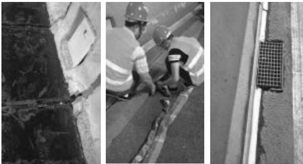
图5 防撞墙的根部密封
