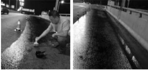
图4 路面涂刷混凝土防水养护剂
