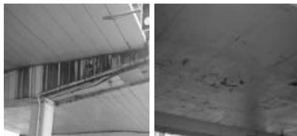
图3 涂刷防水漆后渗漏现象继发
