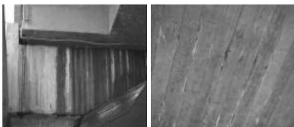
图1 施工节点部位和底面的渗漏现象
